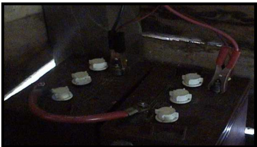
Figura 2.25 Sistema de baterías
