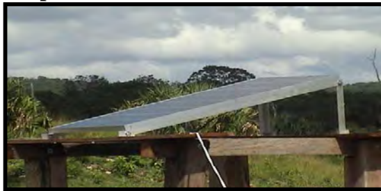
Figura 2.34 Módulos fotovoltaicos
