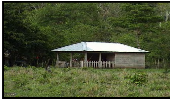
Figura 2.20 Vista de la vivienda
