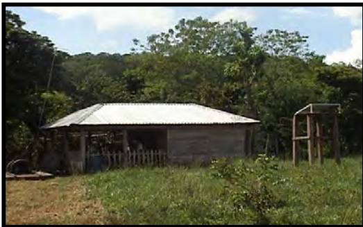
Figura 2.21 Vivienda con los módulos Fotovoltaicos instalados
