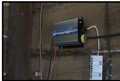
Figura 2.24 Inversor de corriente
