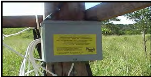
Figura 2.37 Controlador de bomba tipo intemperie
