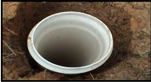
Figura 2.31 Pozo hecho con maquina
