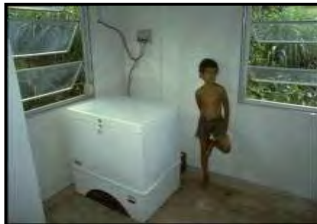
Figura 1.9 Sistema de 12 volts para refrigeración de vacunas [10]
