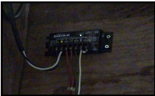
Figura 2.23 Controlador de carga
