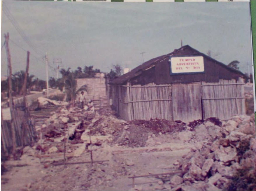
Fotografía 5 Construcción del inmueble religioso
